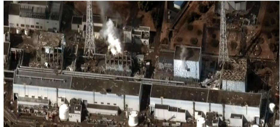
Bild: Zerstörte Blöcke
