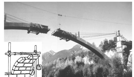
Anreize für den Freivorbau gab es schon im Mittelalter (Gewölbe bei hohen Kirchenschiffen). Auch bei den ersten großen Eisenbrücken wurde diese Technik bereits praktiziert. Für Massivbrücken mit größeren Spannweiten, wie bei der Pitztalbrücke in Tirol, stellen sich jedoch andere Anforderungen. Anstelle des Bogenklappverfahrens wird nach Abspannung über einem Hilfspylon ein Freivorbauerüst montiert und schussweise beide Bogenteile betoniert. Ein Kabelkran leistet Transporthilfe.
