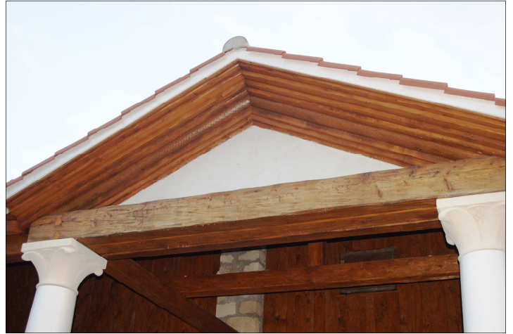
Giebel über dem Haupteingang
